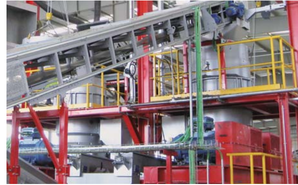
Instalatie de reciclat anvelope in Spania.
