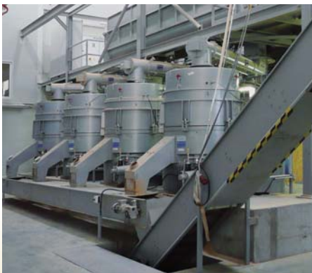
Instalație de peletizat lemn în Ungaria.
